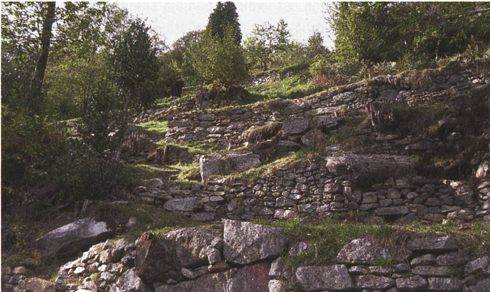
Restaurierte Trockenmauern in Mergoscia
