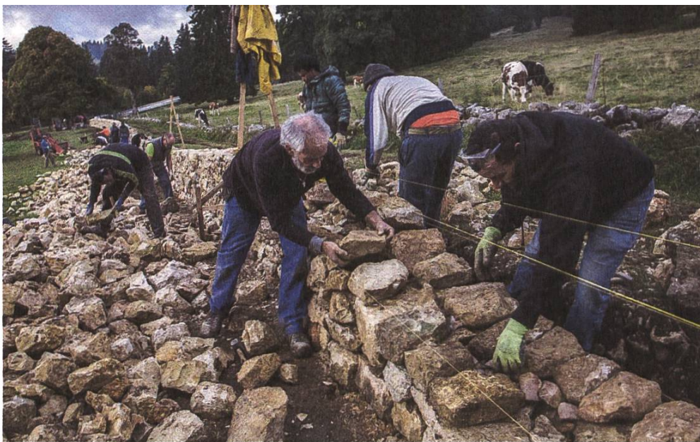
Eine der restaurierten Mauern entlang des «Chemin des Pionniers»
