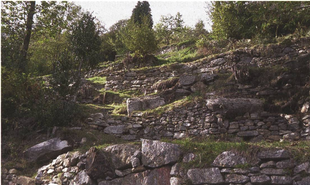
Restaurierte Trockenmauern in Mergoscia
