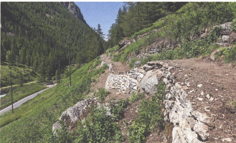
Restaurierte Mauer am historischen Verkehrsweg in Saas-Balen
