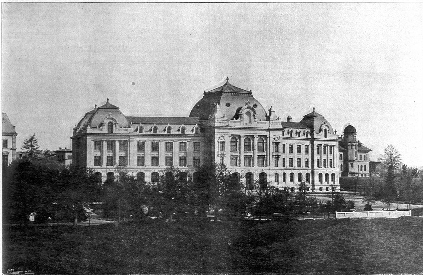
Universitätsgebäude in Bern.
