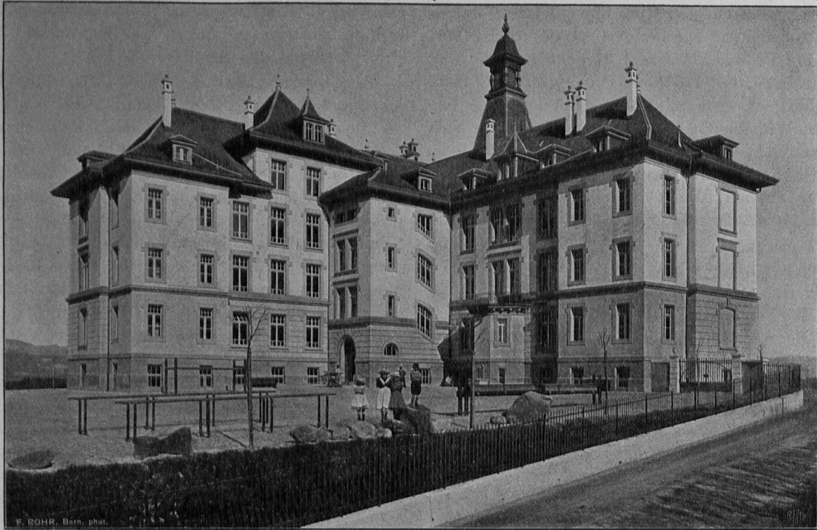
Schulhaus Schosshalde: Nord- und Westfassaden.
