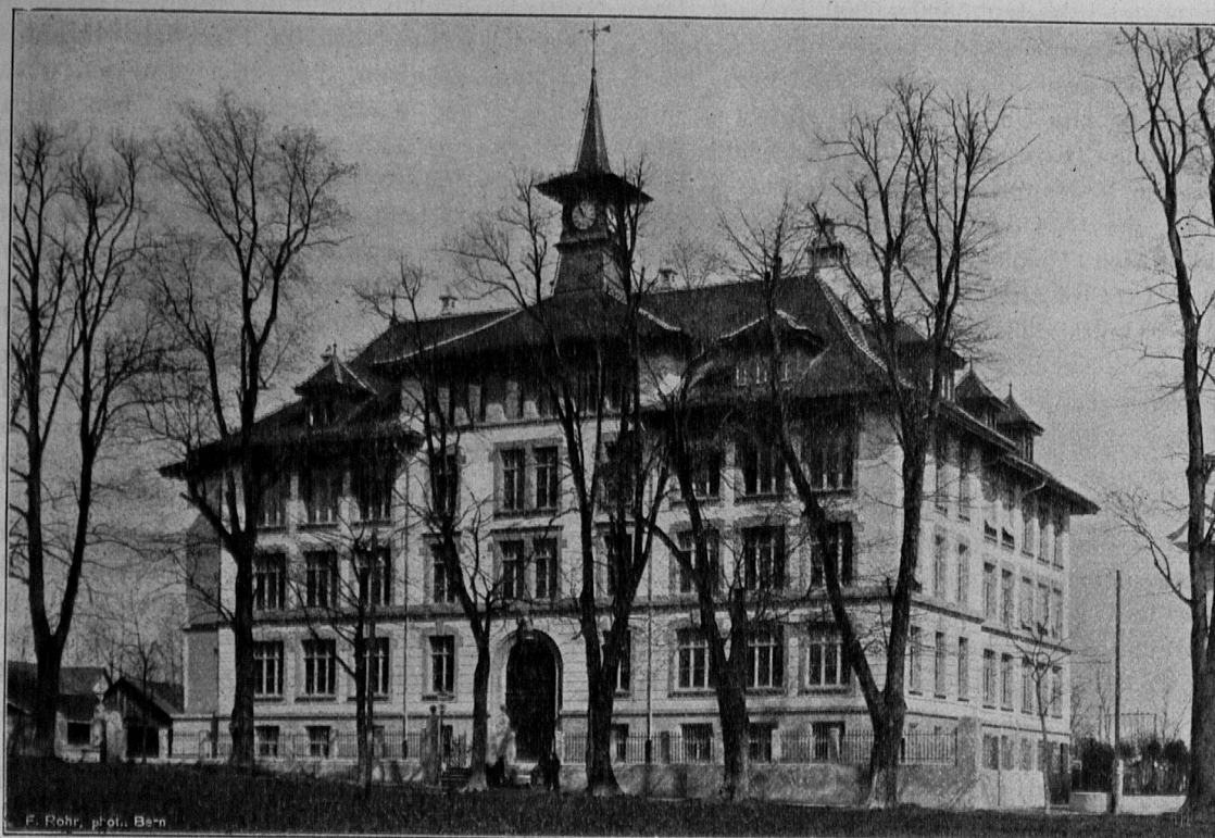
Schulhaus Enge-Felsenau: Ansicht von der Bremgartnerstrasse.
