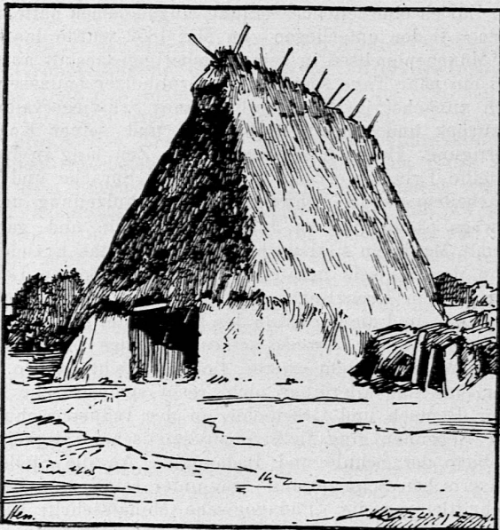
Abbild. 1. Die Dachhütte.
