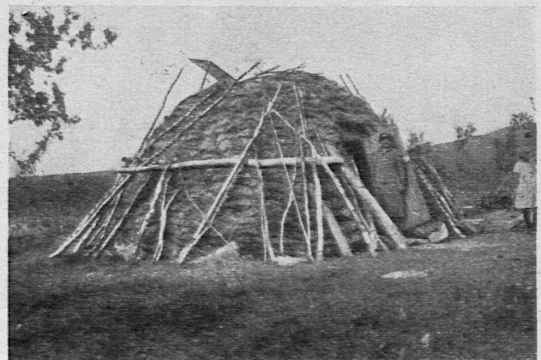
Bild 3. Schulhaus der Lappenschule in Laimulati. Innenbau aus stehenden Birkenstämmen, Verkleidung mit Torf- und Erdklumpen, zur Aussenfassung einzelne Birkenhölzer. Dachklappe für Rauchabzug; Türe aus dem Süden eingeführt, Helligkeit nur durch Dachklappe und Türe, keine Fenster
