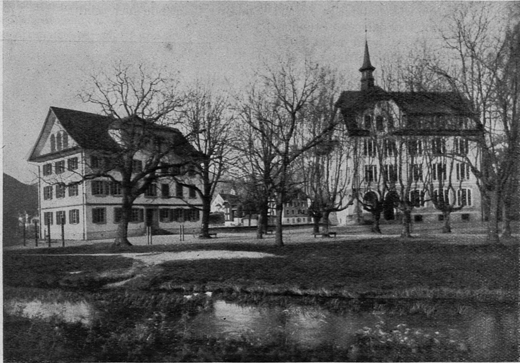
Schulhäuser in Brunnen
