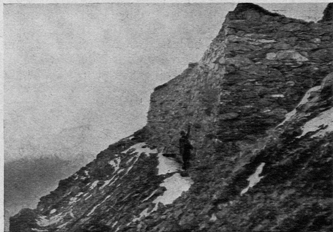
Schutzmauern bei Faldum ob Goppenstein.
