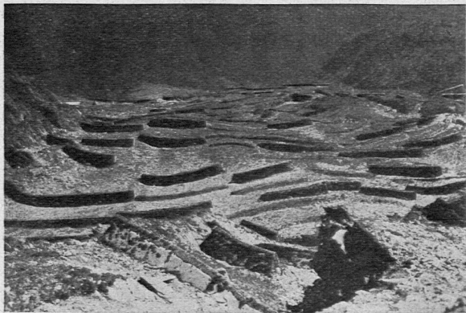
Lawinerverbauungen (Schutzmauer) in der Faldumalp ob Goppenstein. Aufnahme F. Schädelin Monthey
