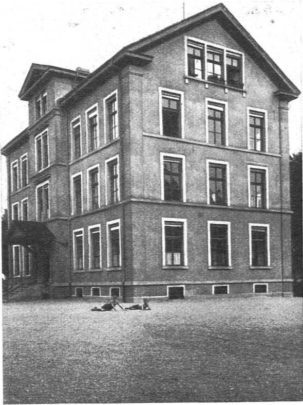
Schulhaus Josefstrasse in Zürich 5.
