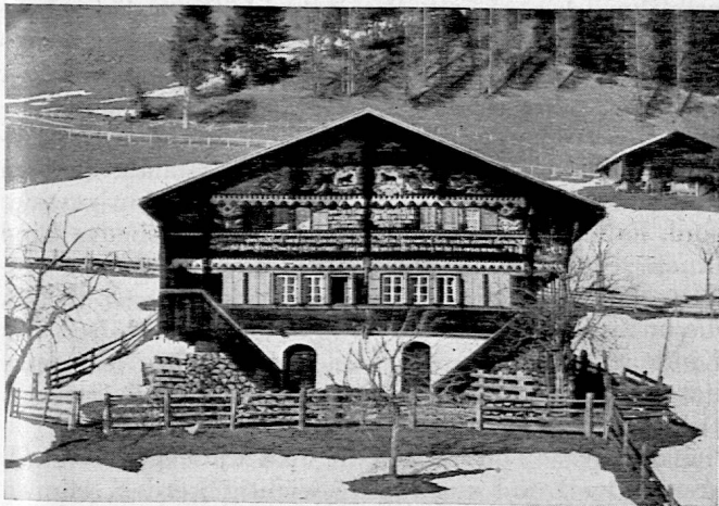
Oberländer Haus. (Haus Bovey, Gutenbrunnen bei Lenk i. S.) Reichgeschmückt mit Schnitzerei, Bemalung und Schrift, verkörpert es mit seiner Form, Lage und Bauart das zierliche, schmucke und viel nachgeahmte «Chalet» des Simmentales und Saanenlandes. Hinten eine Scheune, in der vom Wohnhaus getrennt während einer gewissen Zeit das Vieh gefüttert wird.
