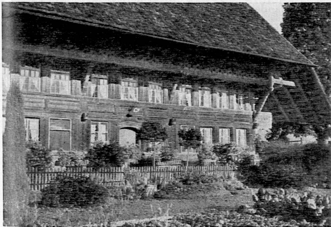
Das Gesicht des Hofes Oberfürten
