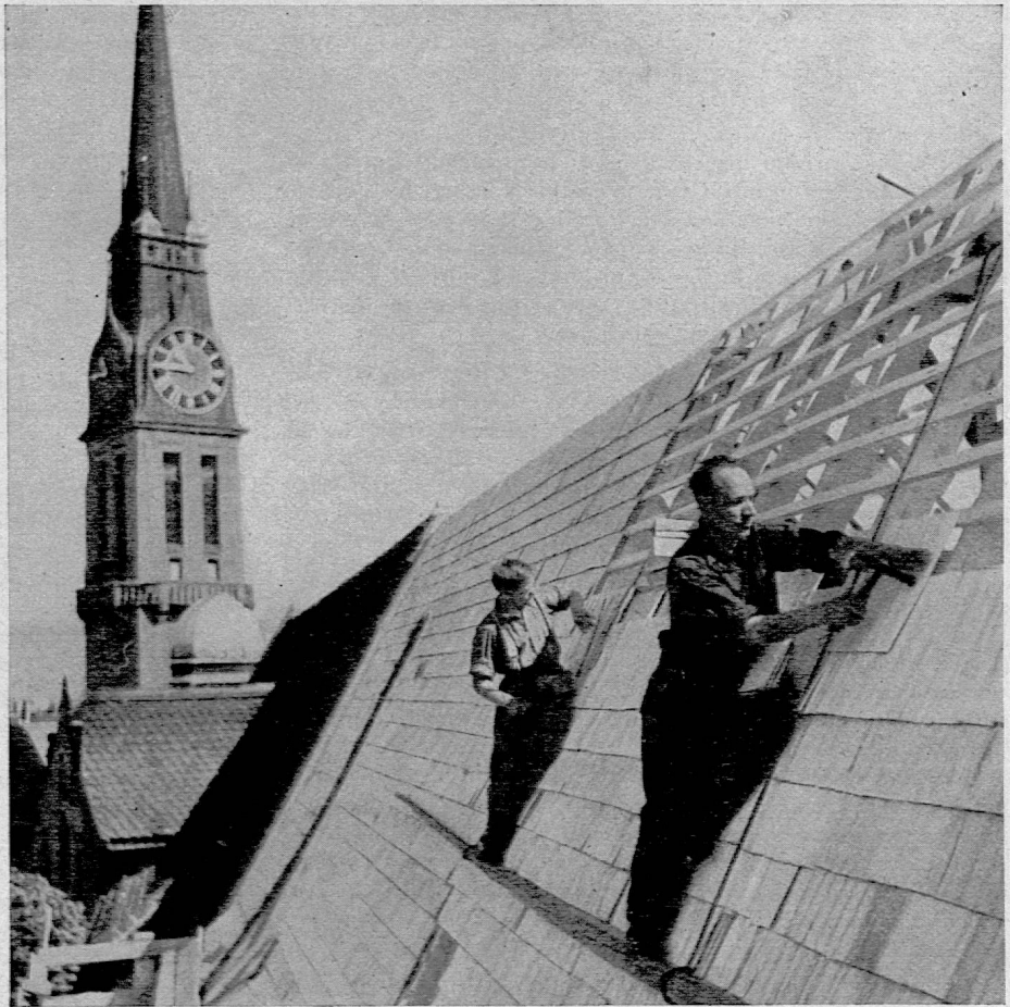
Anforderungen des Dachdeckerberufs: Kräftig, wetterfest, schwindelfrei, geistesgegenwärtig, vorsichtig.
