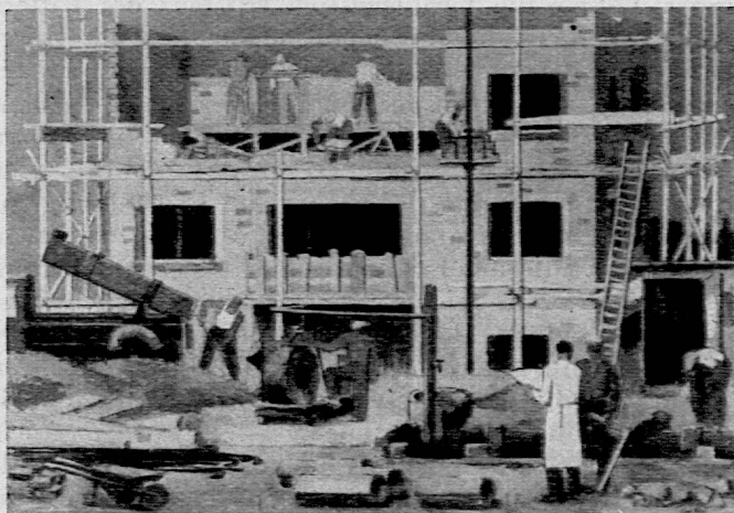
Bauplatz — Maler: Carl Bieri, Bern Serie: Handwerk, Technik, industrielle Werke
