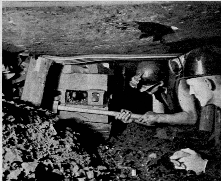
Dieses Bild zeigt, wie sich die Decke langsam senkt und an den stärksten Stützen eindrückt.
