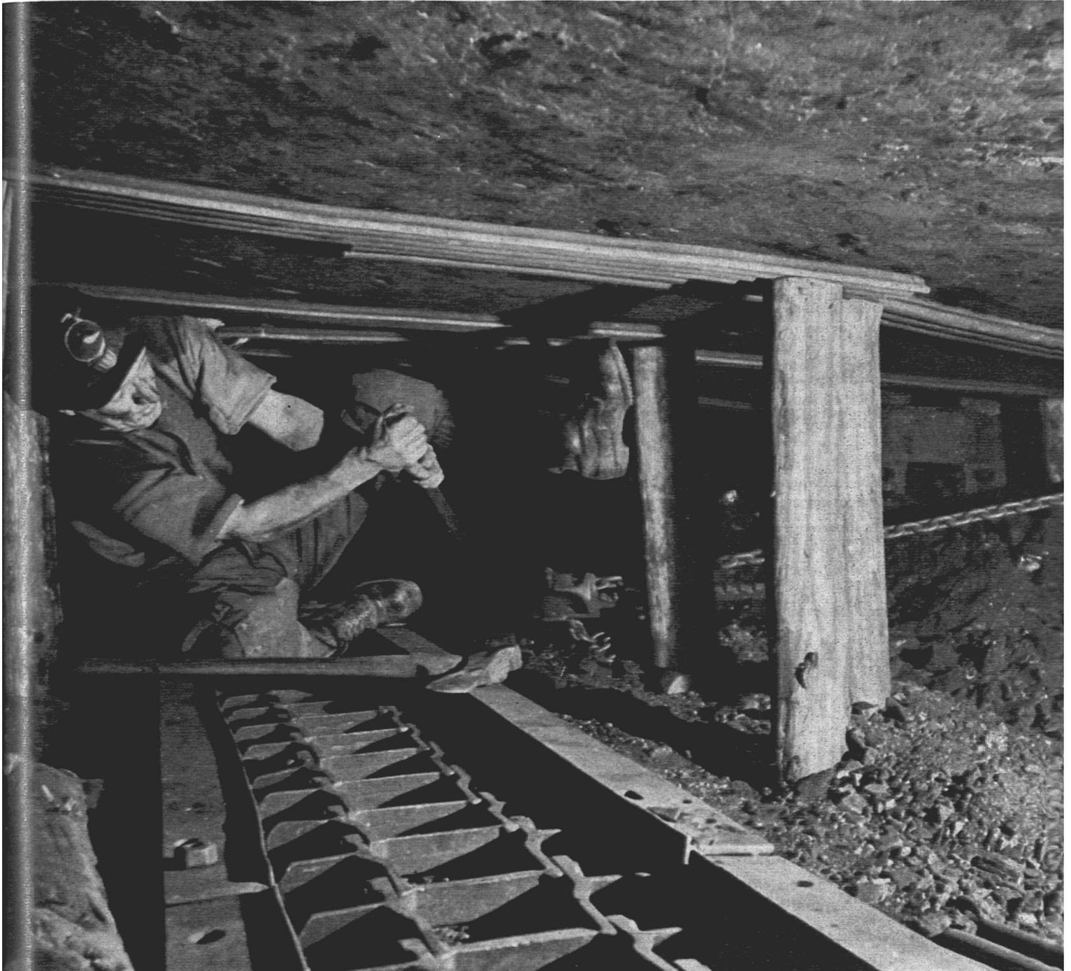
*Ein «Timberer», der mit dem «Sylvester» die hinteren Stützen einreisst. Vorher hat er die Decke am «Kohlengesicht» neu abgestützt und das Förderband (im Vordergrund sichtbar) näher an die Kohle herangeschoben. Man beachte die Knieschoner des Bergmannes. (Siehe der Aufsatz: Besuch eines englischen Kohlenbergwerkes auf Seite 353 dieses Heftes)*
