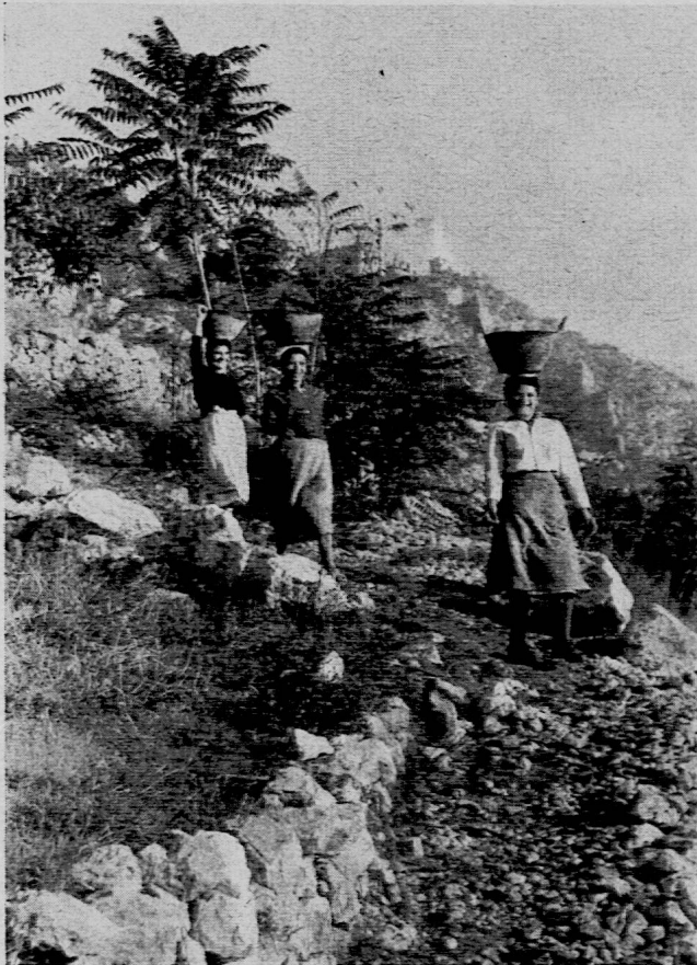
Vorläufig ist in Süditalien die Handarbeit verbreiteter und darum der Lebensstandard tiefer als in entwickelten Ländern. Unermüdet tragen diese Mädchen den Pflaster auf den Köpfen von der Strasse zur Baustelle. Im Hintergrund Monte Cassino mit der neu aufgebauten Benediktinerabtei.
