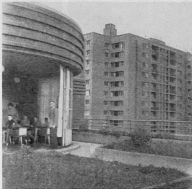
In einem Pavillon auf dem Dach des Schulhauses von Puteaux ist die Spezialklasse untergebracht. Die Glaswand kann auf der einen Seite weggeschoben werden und gibt den Blick frei auf den Dachgarten, in welchem jeder Schüler sein Beet besitzt. — (Die Lehrer sind nicht entzückt darüber, dass dicht neben ihrem vorher völlig freistehenden Schulhaus soeben zwei etwa zwanzigstöckige Hochhäuser gebaut wurden, und zwar durch Staat und Gemeinde, um die katastrophale Wohnungsnot zu lindern.)
