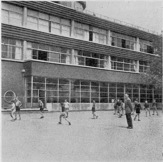
Der «Groupe scolaire» (alle Gemeindeschulen enthaltend) von Puteaux, einer Vorstadt von Paris. Das Schulhaus ist ein gewaltiger Gebäudekomplex und enthält alle erdenklichen Spezialräume, ja sogar ein prächtiges Hallenbad, und blickt von einer Anhöhe weit über Paris hinweg. Es wurde ein Jahr vor dem Zweiten Weltkrieg fertig und kostete damals 30 Millionen franz. Franken, was heute etwa einer Milliarde franz. Franken entsprechen würde. Die Subvention des Staates betrug, da die Arbeitervorstadt Puteaux nicht sehr finanzkräftig war, 60%.
