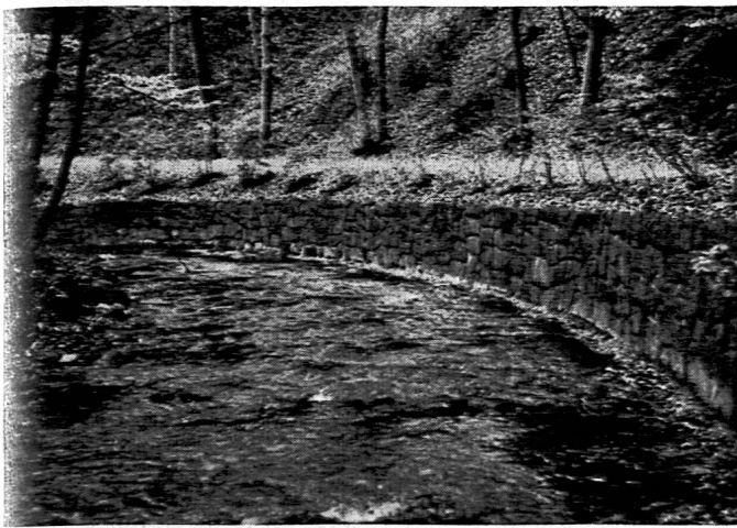
Abb. 10 Der gebändigte Wehrenbach. Meterdicke Betonmauer, in der Kurve wie mit dem Zirkel gezogen.
