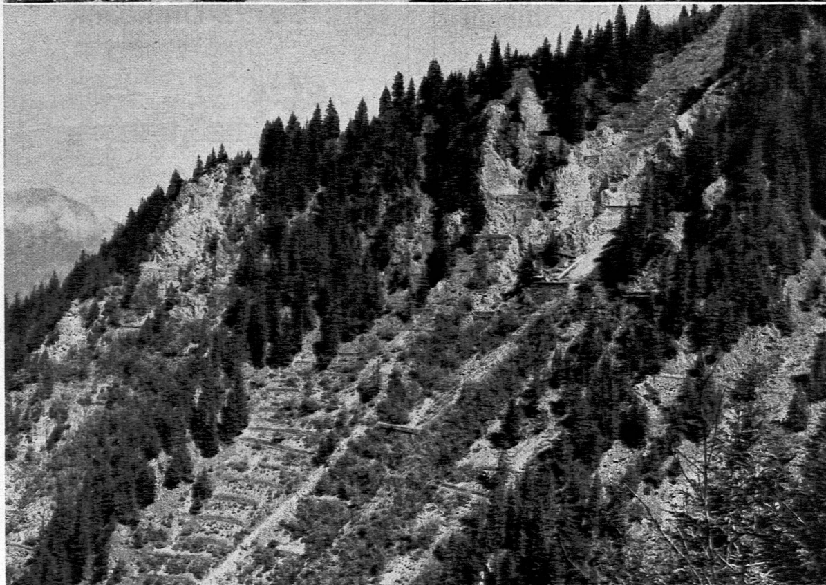
Verbauungs- und Aufforstungsarbeiten an der Lötschbergbahn. Bild oben: Zustand 1926. Bild unten: Zustand 1957. Ein sichtbarer Erfolg der Arbeit des Forstingenieurs stellt sich vielfach erst nach Jahrzehnten ein.
