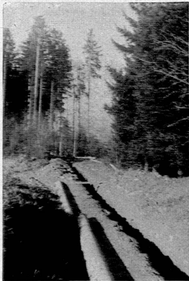
Gasleitung im Bau
