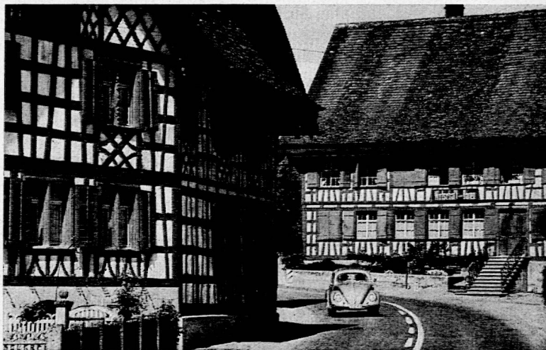
Riegelhäuser in Kesswil (Durchgangsstrasse Kreuzlingen—Romanshorn)
