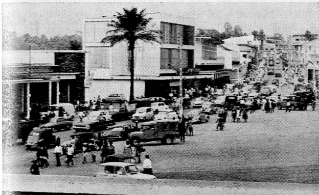
Die Hauptstadt Yaoundé ist eine typisch kolonial-französisch anmutende Neuschöpfung der Nachkriegszeit, seit einem Jahr nun auch Universitätsstadt. — Blick in den untern Teil der schon stark motorisierten, zentralen Geschäftsstrasse. Der grosse Bau links ist das Warenhaus «Printania». Photo Dr. Kündig.
