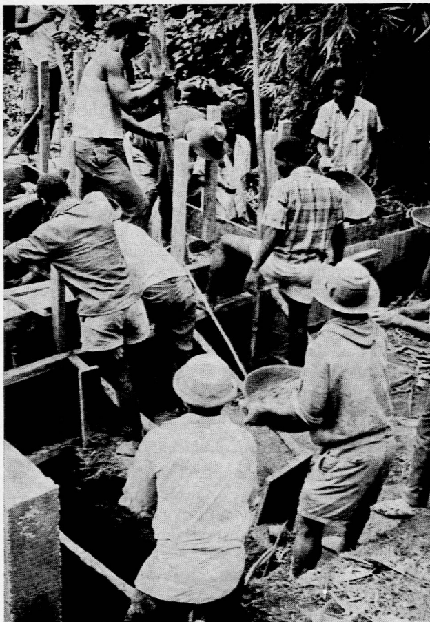
Bau eines neuen Wasserpunktes im südlichen Waldland. Die Dorfbewohner leisten Fronarbeit und helfen wacker mit. Photo Helvetas/Kreidler.
