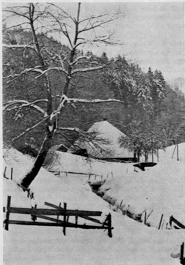
Das Schulhaus Hinter-Biembach, das «Hungihüsl», erbaut: 1782.
