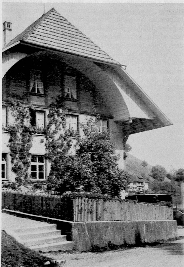
Das Schulhaus von 1833, abgebrochen am 9. November 1965. Rechts im Hintergrund das Lehrerhaus, erbaut: 1931.
