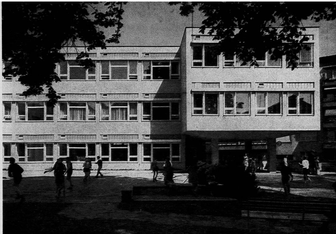
Heilpädagogische Hilfsschule der Stadt Zürich. Schulhaus Gotthelfstrasse
