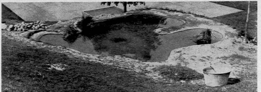
Auffüllen und erste Bepflanzung. Seggen- und Schilfstöcke lassen sich mit viel natürlichem Bodengrund direkt auf den Beton stellen. Mit den beim Aushub aufgesparten Rasenziegeln lässt sich die Umgebung verkleiden.
