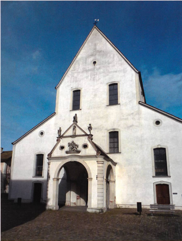
Abb. 2: Ansicht der Kirche St. Martin in Rheinfelden von Südwesten.
