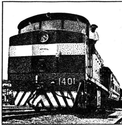
Hier eine der 33 Eisenbahnlokomotiven Nigerias, ausgerüstet mit dem erfolgreichen Sulzer-Traktionsmotor 6LDA 28. Er entwickelt 1400 PS bei 800 U/min. Allein in Grossbritannien sind zum Beispiel 600 sowie auf den Schmalspurstrecken Afrikas und Australiens 70 Motoren dieses Typs eingesetzt.
