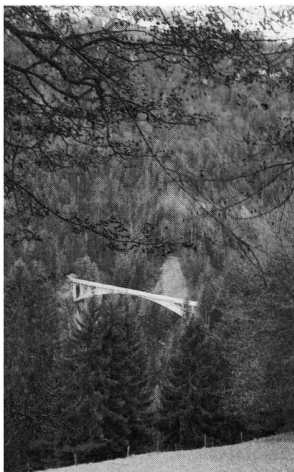
Salginatobel-Brücke bei Schiers (1929/30). Architekt: Robert Maillart Photo: René Furer
