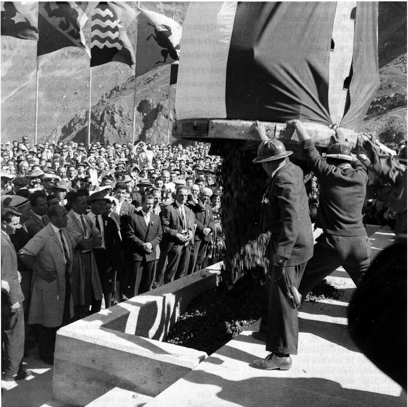
Bau der Grande Dixence. Feier aus Anlass der Leerung des letzten riesigen Betonkübels am 22. September 1961. Photo: Philippe Schmid
