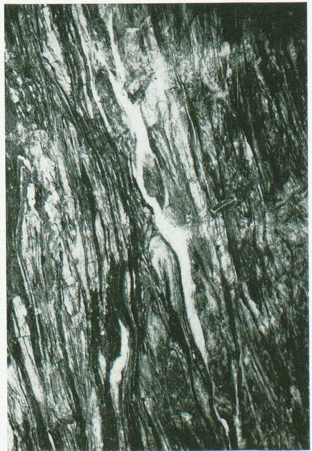
Photo 18. Gipslagen parallel zur alpinen Schieferung. Zuleitungsstollen, oberer Teil, m 30.
