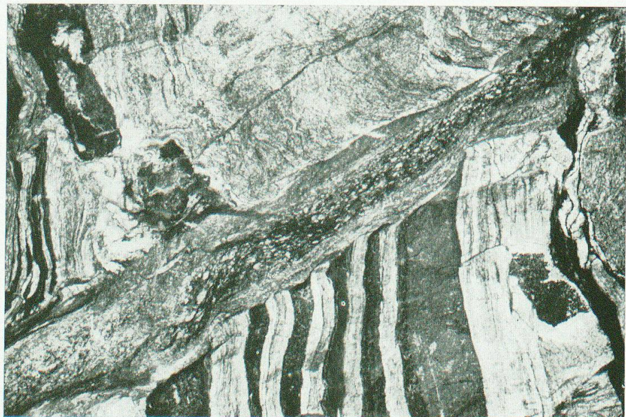
Photo 6. Ähnlicher Bewegungshorizont wie in Photo 5, mit recht grossem Versetzungsbetrag. Breite des Bildes ca. 1,5 m. Zuleitungsstollen, oberer Teil, m 548 (First).
