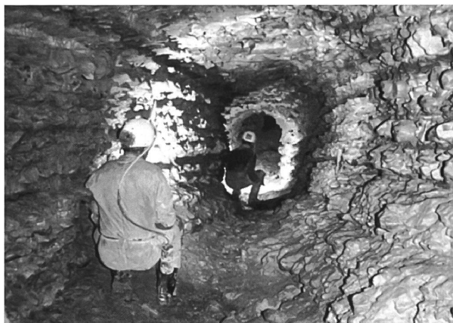
Foto 2. Caverna Generosa, galleria del «Siam Vivi». In questa grotta, che si apre a 1450 m s.l.m., sono stati rilevati i tassi più elevati di NO 2 .
