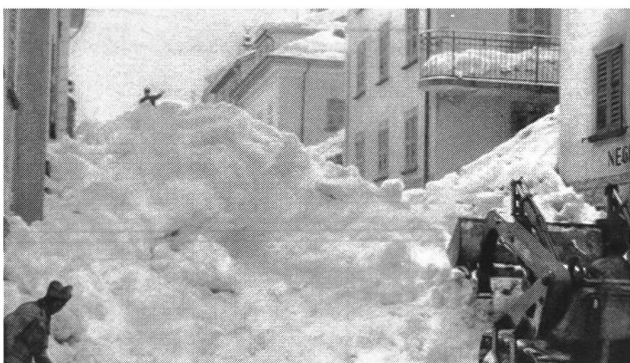
Fig. 2 - Un'immagine di Airolo sotto la valanga del 1951. Le eccezionali neviccate di inizio anno, con le alluvioni estive e autunnali, furono l'evento naturale più disastroso del XX° Secolo.
