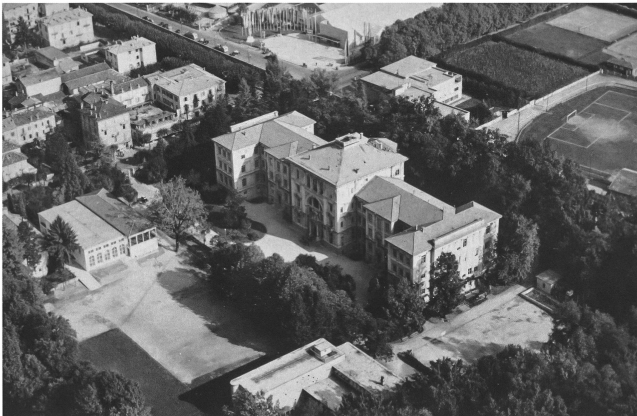
Fig. 7 – Panoramica del Liceo Cantonale agli inizi degli anni '50. La stazione meteorologica si trova a destra in basso nell'immagine, con l'area cintata nella quale erano sistemati le capannine e i pluviometri e l'«osservatorio» per il barometro e altri strumenti. L'anemometro e l'eliografo si trovavano invece sulla piccola terrazza del liceo (foto STSN).
