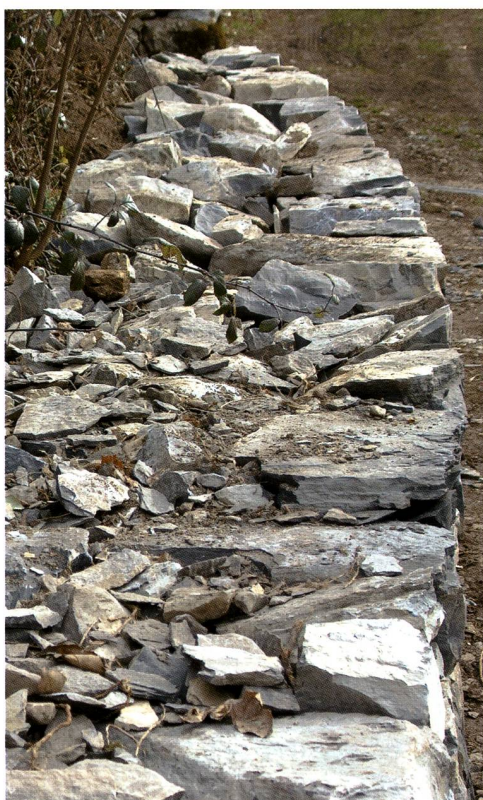
Fig. 3 – Muro in costruzione lungo la Strada di Circolo.
