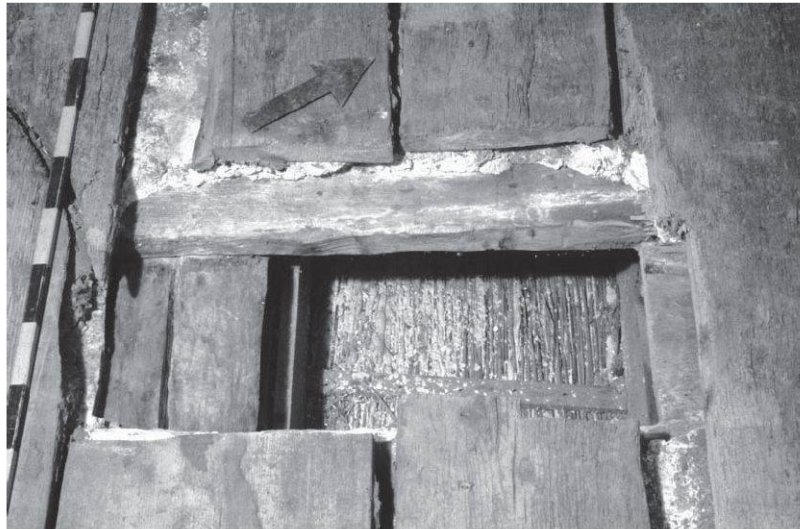
Abb. 16 Zug, St.-Oswalds-Gasse 10. Raum 11; Blick in den mehrschichtigen Boden. Auf den Deckenbrettern von 1447 der Kalkmörtelestrich um 1480, darüber die zur selben Zeit verlegten Bodenbretter.
