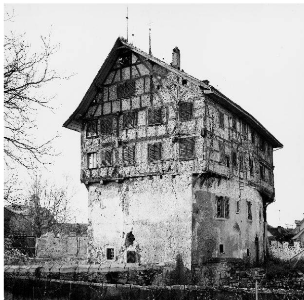
Abb. 19 Burg Zug. Die Ost- und Nordfassade der Burg Zug vor der Restaurierung 1978. An der Nordfassade (rechts) bildet der Bohlenständerbau von 1355 die Grundkonstruktion des unteren Fachwerkgeschosses.
