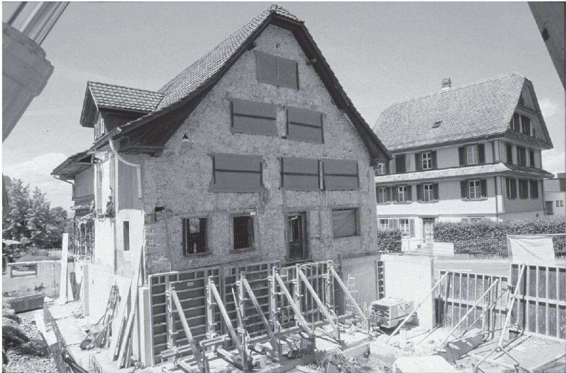
Abb. 21 Adler Allenwinden. Das 1768 erbaute Gasthaus während des Umbaus im Jahr 2009. Blick nach Nordwesten.
