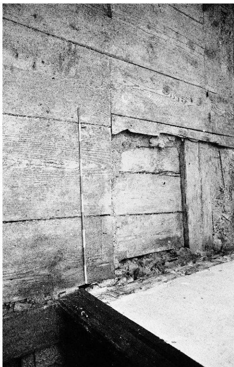
Abb. 20 Burg Zug. Boden des Nordwestraums im dritten Obergeschoss des Nordannexes. Unter dem Bretterboden sind die Deckenbalken und die eingeschobenen Bretter des «Blindbodens» ersichtlich. Im Zwischenraum fanden sich zahlreiche Funde.
