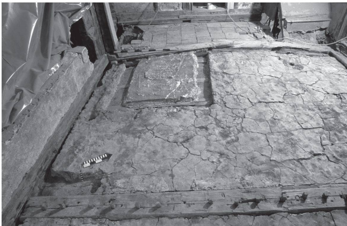
Abb. 15 Zug, St.-Oswalds-Gasse 10. Raum 10; Lehmörtelstrich (1447d) mit ausgespartem Fundament des primären Ofens im Südwest-Bereich des Raumes.
