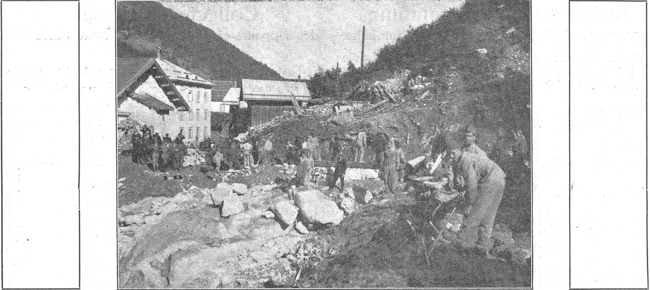
Sappeure des Sapp.-Bat. 6 bei den Räumungsarbeiten in Tavanasa, Sappeurs du bat. 6 des sapeurs aux travaux de déblaiement à Tavanasa (Grisons).
