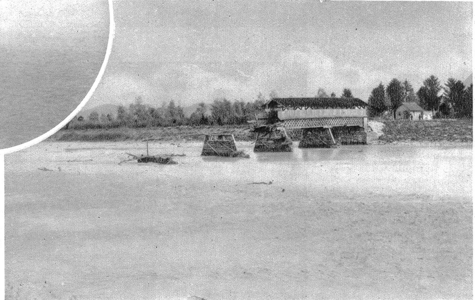
Bild rechts: Ueberreste der Strassenbrücke über den Rhein zwischen Schaan und Buchs.
