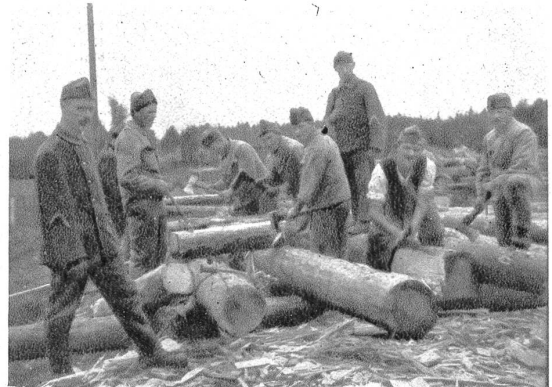
Oben: Abbundarbeiten für die Dienstbrücke über den Rhein unterhalb Bendorf (Liechtenstein).
