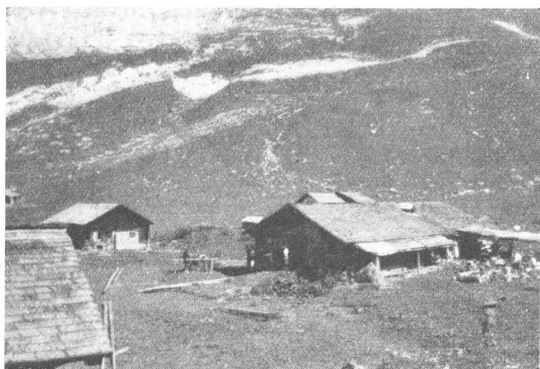
Kantonnements und Stallungen auf Engstlenalp. Cantonnements et écuries à Engstlenalp.
