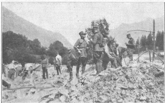
Lenk. — Wegräumungsarbeiten (Bat. Kdt. Major Zeugin). La Lenk. Travaux de déblaiement. (Major Zeugin, Cdt. du bat.).
