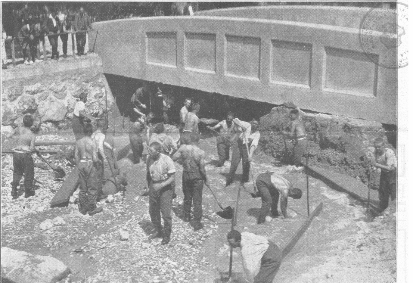
I.-R. S. III/4 in Luzern bei den Räumungsarbeiten unter der Lielibach-Brücke in Beckenried. (Dubois) L'E. R. I. III/4 à Lucerne occupée à des travaux de déblaiement sous le pont du Lielibach à Beckenried.
