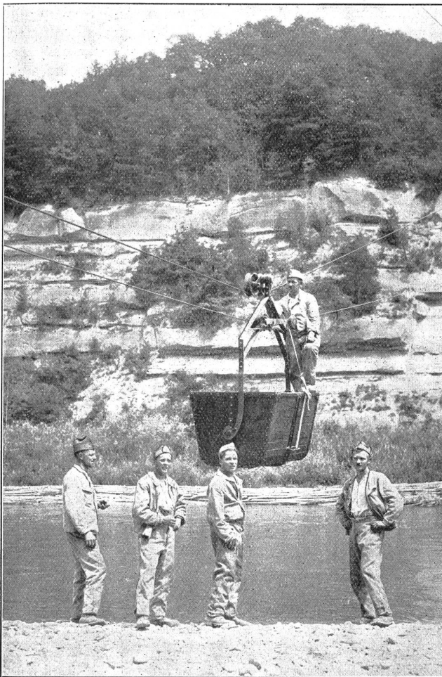
Seilbahnbau des Sap. Bat. 3 W. K. 1929. — Transportwagen auf der Strecke.
