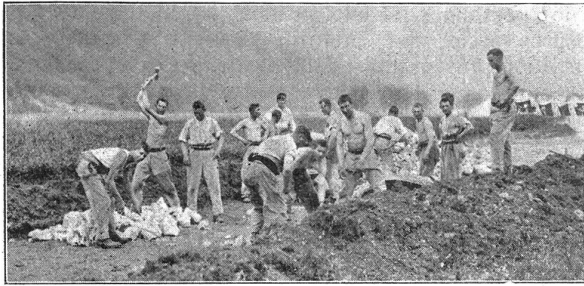
Mit vereinter Kraft: Flieger-Rekruten beim Strassenbau. Et avec les bras de tous: recrues des troupes d'aviation construisant une route.
