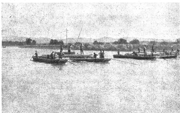
Zerlegen einer Pontonbrücke in einzelne Glieder.
