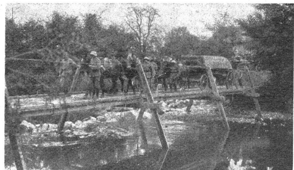
Bau einer Bockbrücke aus Ordonnanz-Material. Construction d'un pont de chevalets avec du matériel d'ordonnance.
