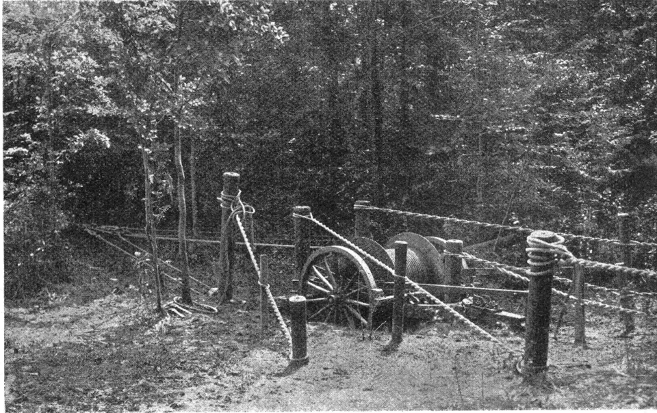
Schertauwinde mit Verankerung des Schertaus. Treuil de cinquenelle avec ancrage de la cinquenelle.
