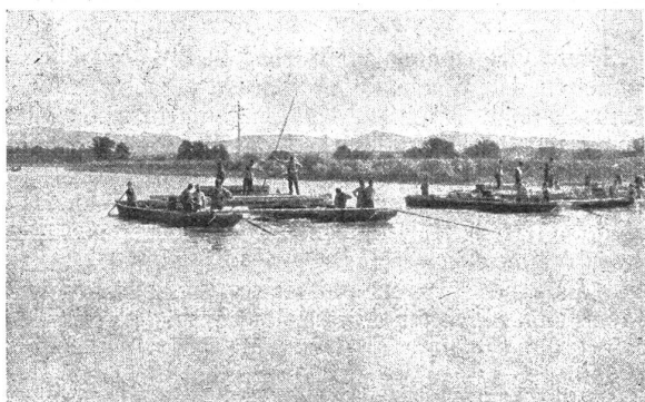
Zerlegen einer Pontonbrücke in einzelne Glieder.
