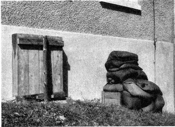
Passiver Luftschutz. Luftschutz-Raum. Die äußere Abdichtung der für Luftschutzräume vorgesehenen Keller erfolgt entweder durch eine starke Auflage von Sand- und Erdesäcken (Fenster rechts) oder aber durch einen Holzverschlag von mindestens 50 cm Tiefe, der mit fest zusammengestampfter Erde ausgefüllt wird (Fenster links).
