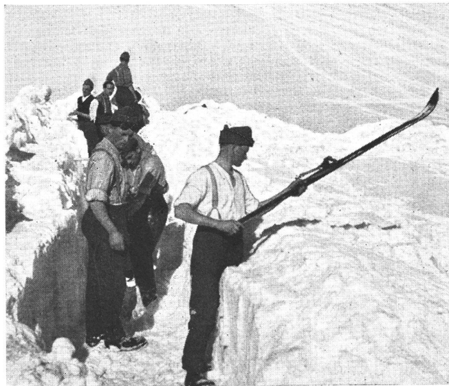
Gebirgsinfanteristen beim Ausheben eines Schützengrabens im Schnee. Mit einem Ski werden die Brustwehren festgeschlagen.
