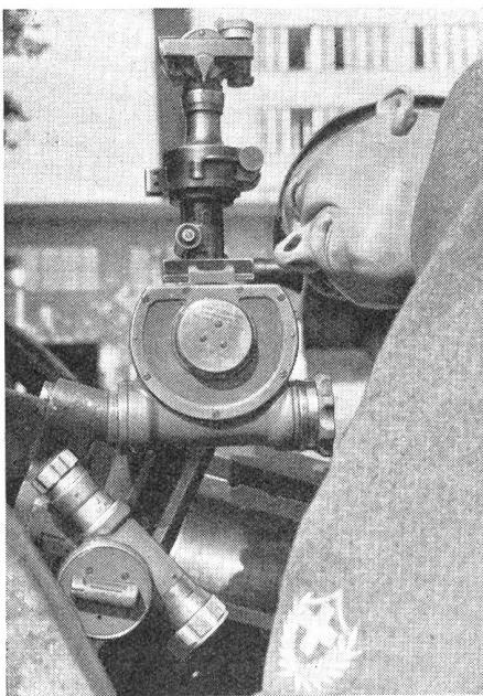
**Artilleriearbeiten.** Richtübungen am 7,5-cm-Feldgeschütz. Das Nachrichten mit dem Panorama-Aufsatz bei eingespielter Maximalelevation des Geschützrohrs ist mit einigen Schwierigkeiten verbunden.
