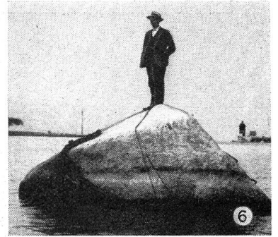
La pierre du Niton, rade de Genève, dans laquelle est scellé le repaire fondamental du nivellement fédéral.
