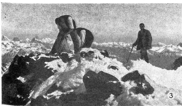
Aides ingénieurs érigeant le point trigonométrique au sommet de la Bernina (4055 m au-dessus de la mer).
