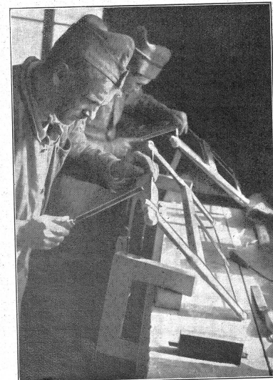
Mit der Instandstellung der auf den Baustellen unbrauchbar gewordenen Werkzeuge sind dauernd einige Spezialisten beschäftigt. (A N 086.)
