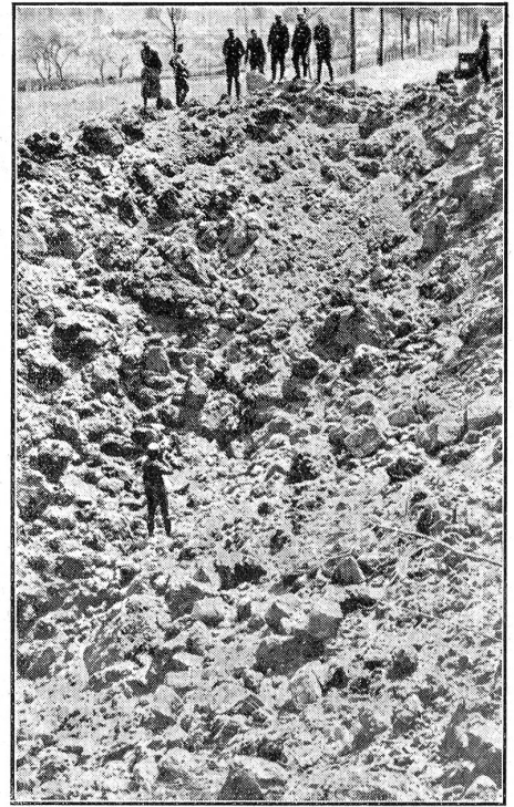
Eine Straßensprengung von außerordentlichem Ausmaße für die Verzögerung des deutschen Vormarsches.
