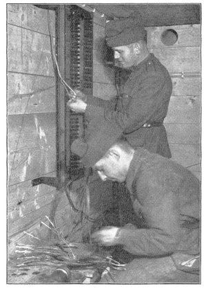
Das Verspleißen der Kabeladern und das Montieren der Verteiler an den Endstationen sind delicate Arbeiten, die größte Zuverlässigkeit verlangen. (A Er 0302.)
