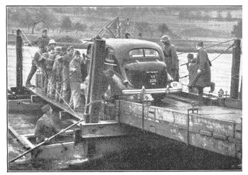
Die Drahtseilgeländer sind noch nicht gestreckt, als der erste Wagen zum Uebersetzen auf die Fähre dirigiert wird. Knapp 45 Minuten dauerte der Einbau der Fähre. (A Er 0305.)
