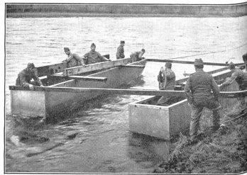
Auf die Länge der Stützbalken wird der linke Ponton abgestoßen, indes in der Mitte bereits mit dem Aufbau der Ladebrücke begonnen wird. (A Er 0307.)
