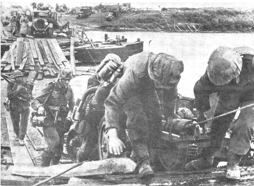
Schützen einer deutschen Panzerdivision beim Vorbringen ihrer Fahrzeuge über eine provisorische Donbrücke.
